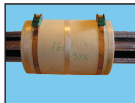
Armeringstape monteres om isoleringshalvskåle 3 steder.
